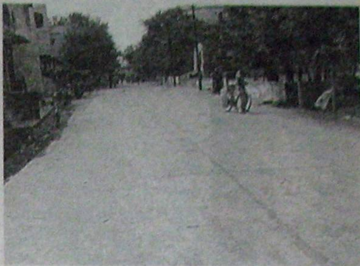
గ్రామంలో ప్రతి రోడ్డు సిమెంటు రోడ్డే.
