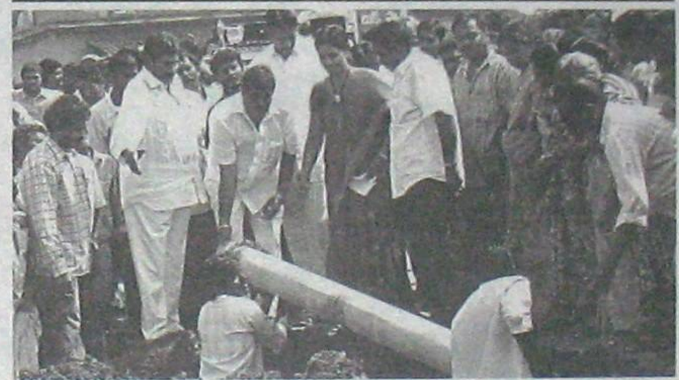
నెల్లూరు కళ్యాణ్ నగర్ లో మంచినీటి సైఫులైజర్ల పనులను ప్రారంభిస్తున్న రూరల్ ఎమ్మెల్యే వివేకానందరెడ్డి, నగర ఎమ్మెల్యే శ్రీధరకృష్ణారెడ్డి, మేయర్ భానుశ్రీ, కార్పొరేటర్ నరేంద్రరెడ్డి.
