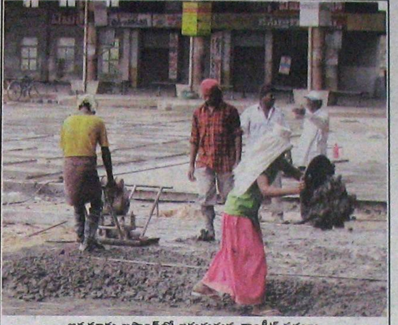
ఆత్మకూరు బస్టాండ్లో జరుగుతున్న కాంక్రీట్ పనులు.
