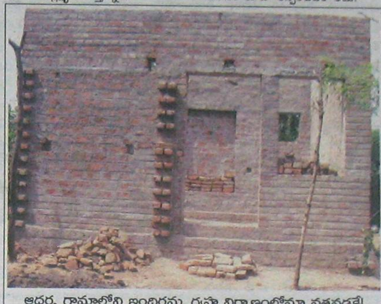
ఆదర్శ గ్రామాల్లోని ఇందిరమ్మ గృహ నిర్మాణంలోనూ నక్షత్రదకే!
