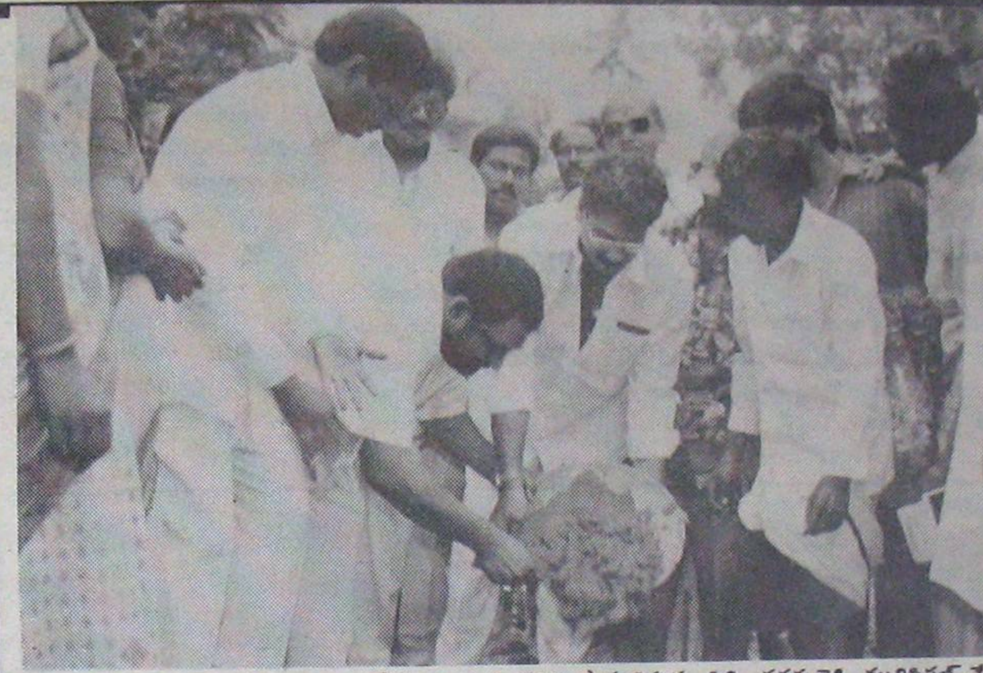
నెల్లూరు కళ్యాణి ఫిలిమ్స్ వద్ద నిమెంటు రోడ్డు నిర్మాణపు పనిని ప్రారంభిస్తున్న వి. ప్రసన్నరెడ్డి, మునిసిపల్ ఛైర్మన్ ఆనం వివేకానందరెడ్డి.
