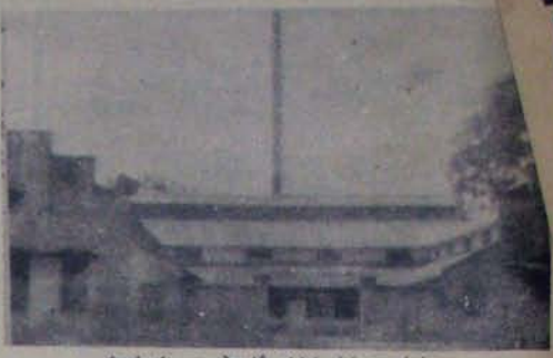
గుడూరు గాజుఫ్యాక్టరీ భవన సముదాయము
