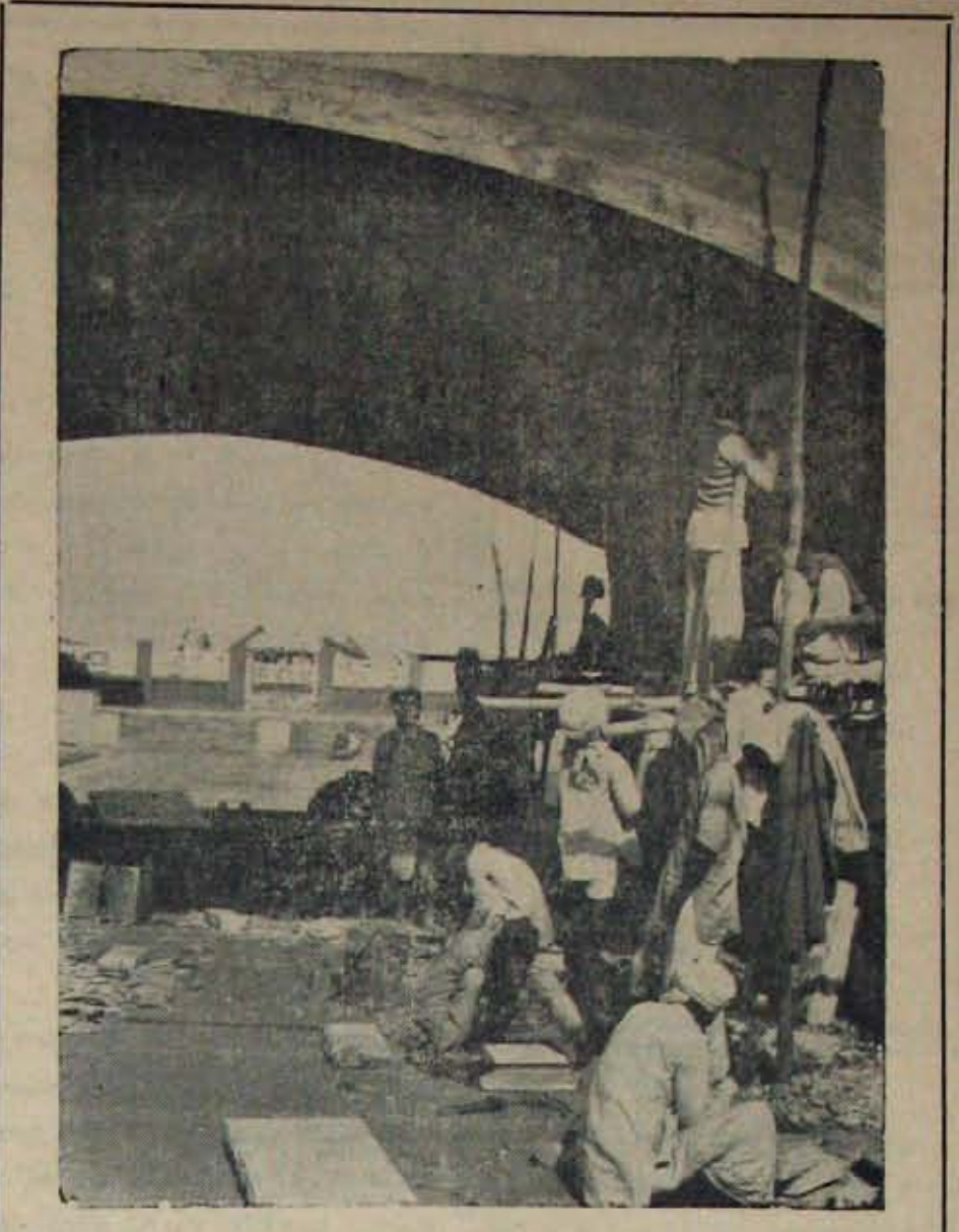
ధిల్లరాజుపూట్లోని గాంధీజీ సమాధినిర్మాణం ప్రారంభమై, ప్రధమ దశ వచ్చేసరివత్సరం పూర్తికానున్నది. మెరుగుచెట్టిన నల్లరాతిలో సమాధినిర్మాణం జరుగుతుంది. సమాధికిపోయే మార్గంలో నిర్మించబడుతున్న నాలుగు అర్చిలలో ఒకదానివద్ద పనిజరుగుతుండడం చిత్రంలో చూడవచ్చు. చిత్రంలో వెనుకకనుపించేదే బాపూజీసమాధి.
